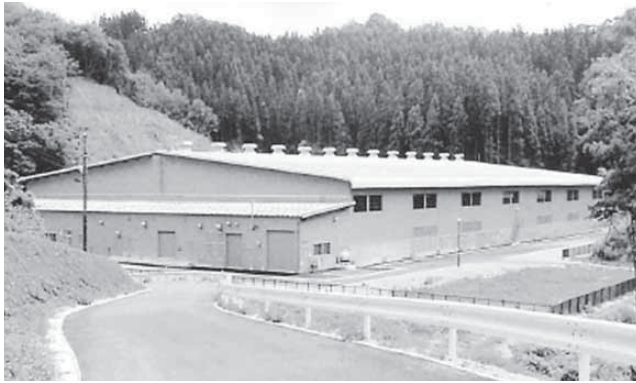
▲例：大曲仙北広域南外一般廃棄物最終処分場 (秋田県大仙市)
